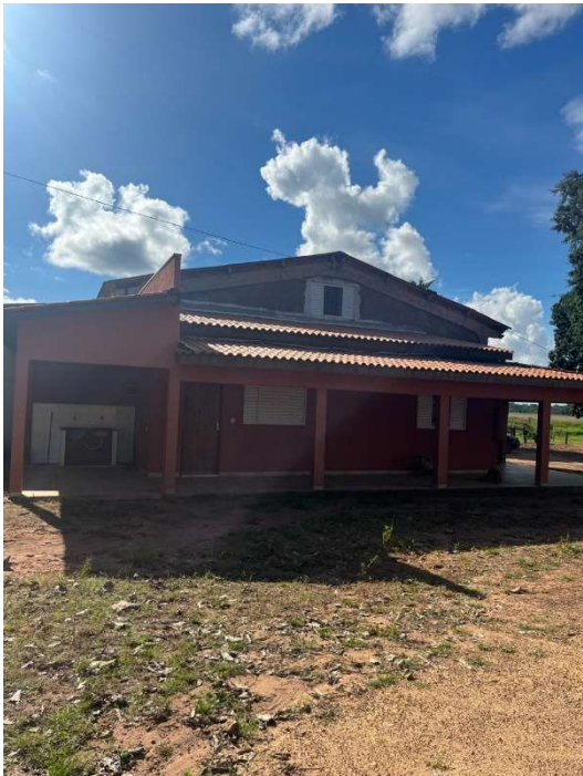
Foto01– Casa sede onde reside os Requerentes.
