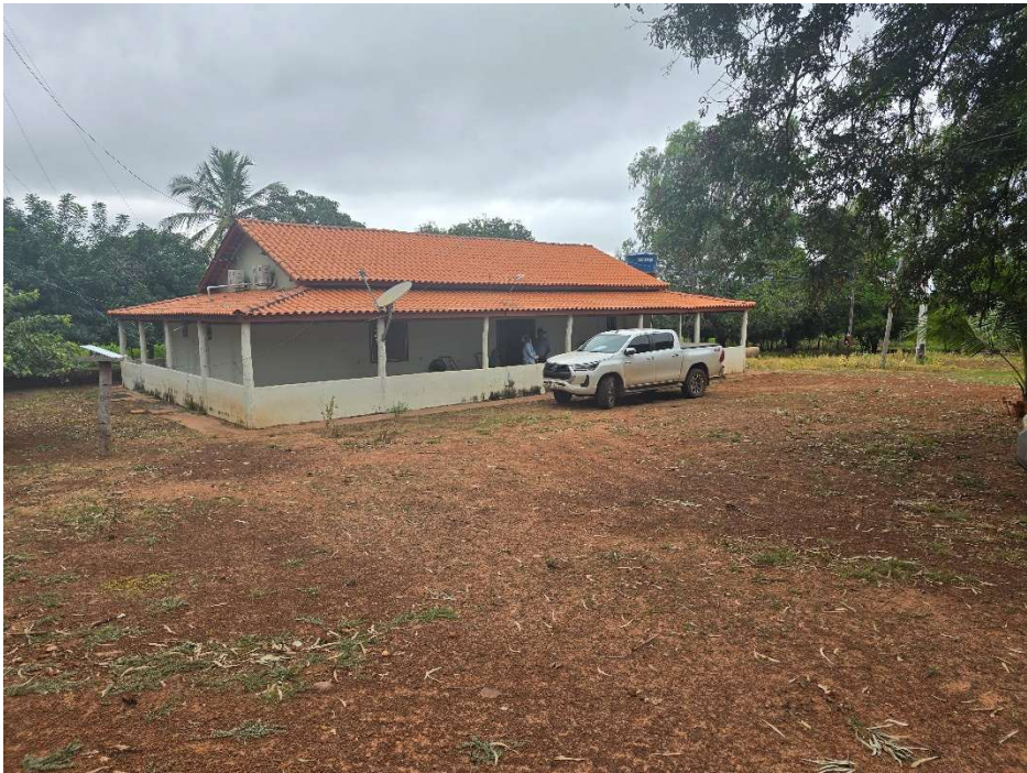
Foto01– Casa sede onde reside os Requerentes.
