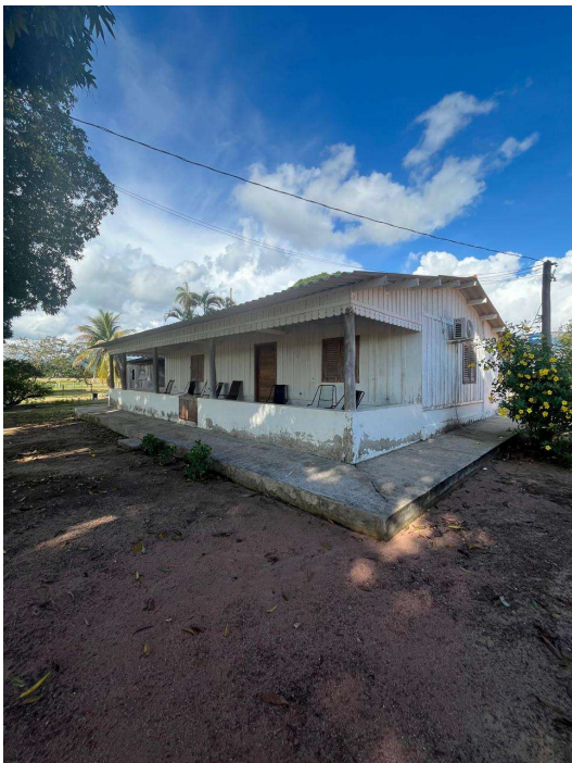
Foto02– Casa dos Funcionários
